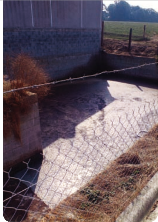
Une fosse à lisier en Bretagne...
